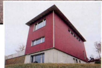
CORBAZ (FR) Dans la maison de l'architecte Conrad Lutz, le choix des matériaux a été fait en fonction de leur impact sur l'environnement: façades en bois et planchers en mélèze huilé. En haut, le système d'aération douce, qui permet une circulation optimale de l'air.
