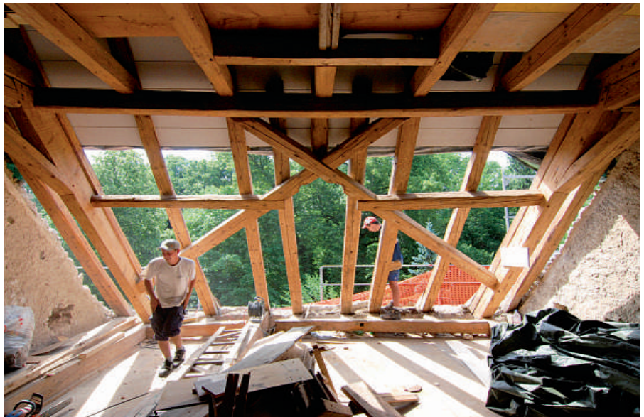
La toiture a été isolée avec de la ouate de cellulose recyclée. Les tuiles d'origine, faites à la main, ont été déposées, nettoyées et remises en œuvre sur place, tout en étant complétées par d'autres tuiles neuchâtoises anciennes récupérées dans les alentours.
