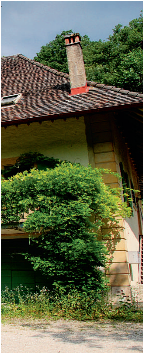
La toiture a été isolée avec de la ouate de cellulose recyclée. Les tuiles d'origine, faites à la main, ont été déposées, nettoyées et remises en œuvre sur place, tout en étant complétées par d'autres tuiles neuchâtoises anciennes récupérées dans les alentours.
