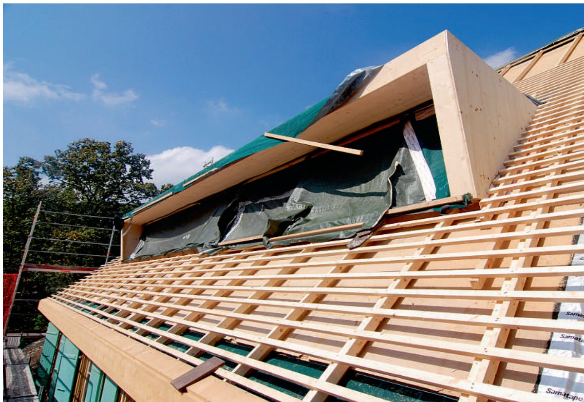
Le volume de la toiture a été rendu habitable par l'ajout d'une grande lucarne en bandeau.
